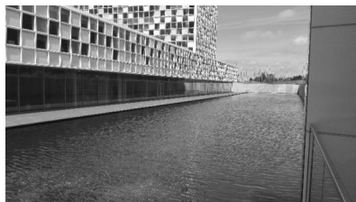
Illustration 3. Cours d'eau entourant le bâtiment, une fois passé le bloc de sécurité (photographie prise le 20/06/2016 à La Haye)
